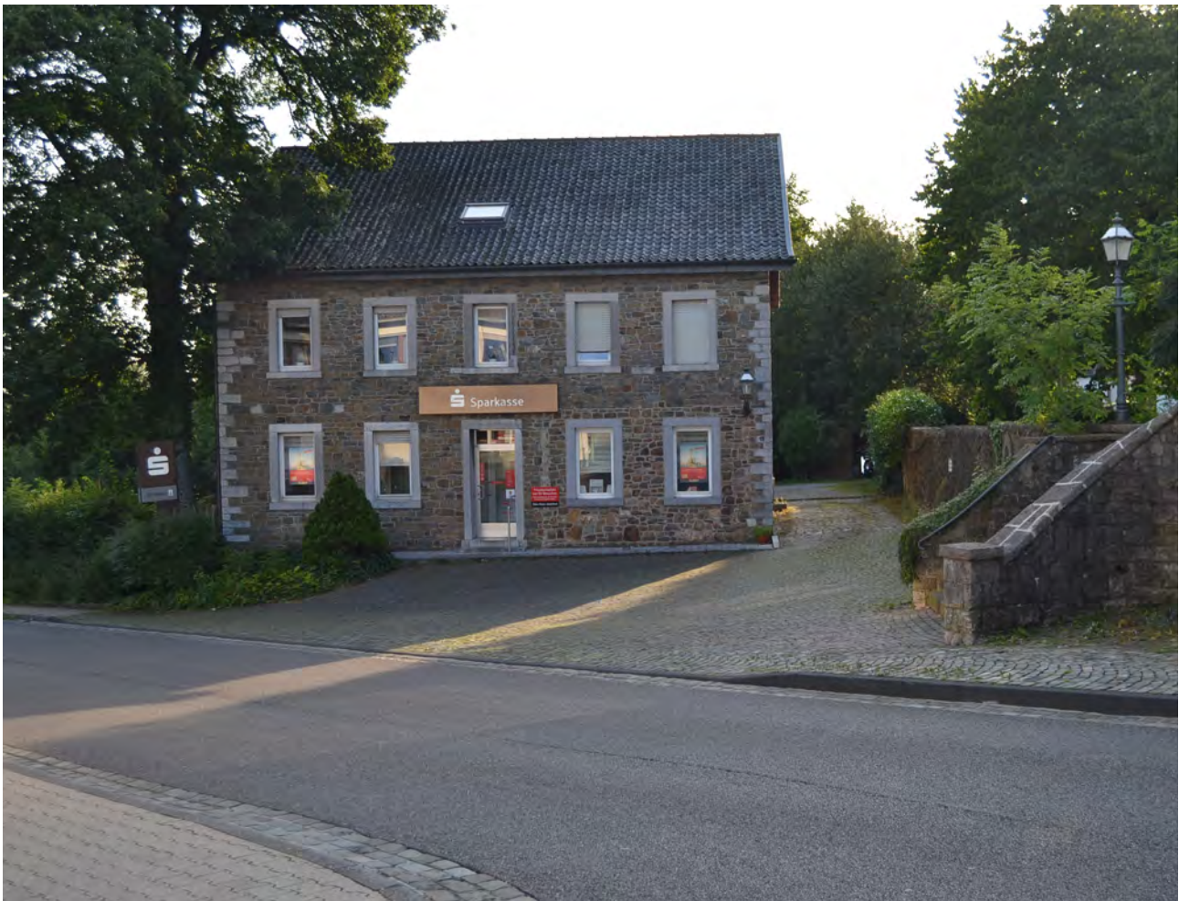
Abb. 19 Bautypologie - traufständiges fünfschichtiges Bruchsteinhaus / ISL, August 2015
