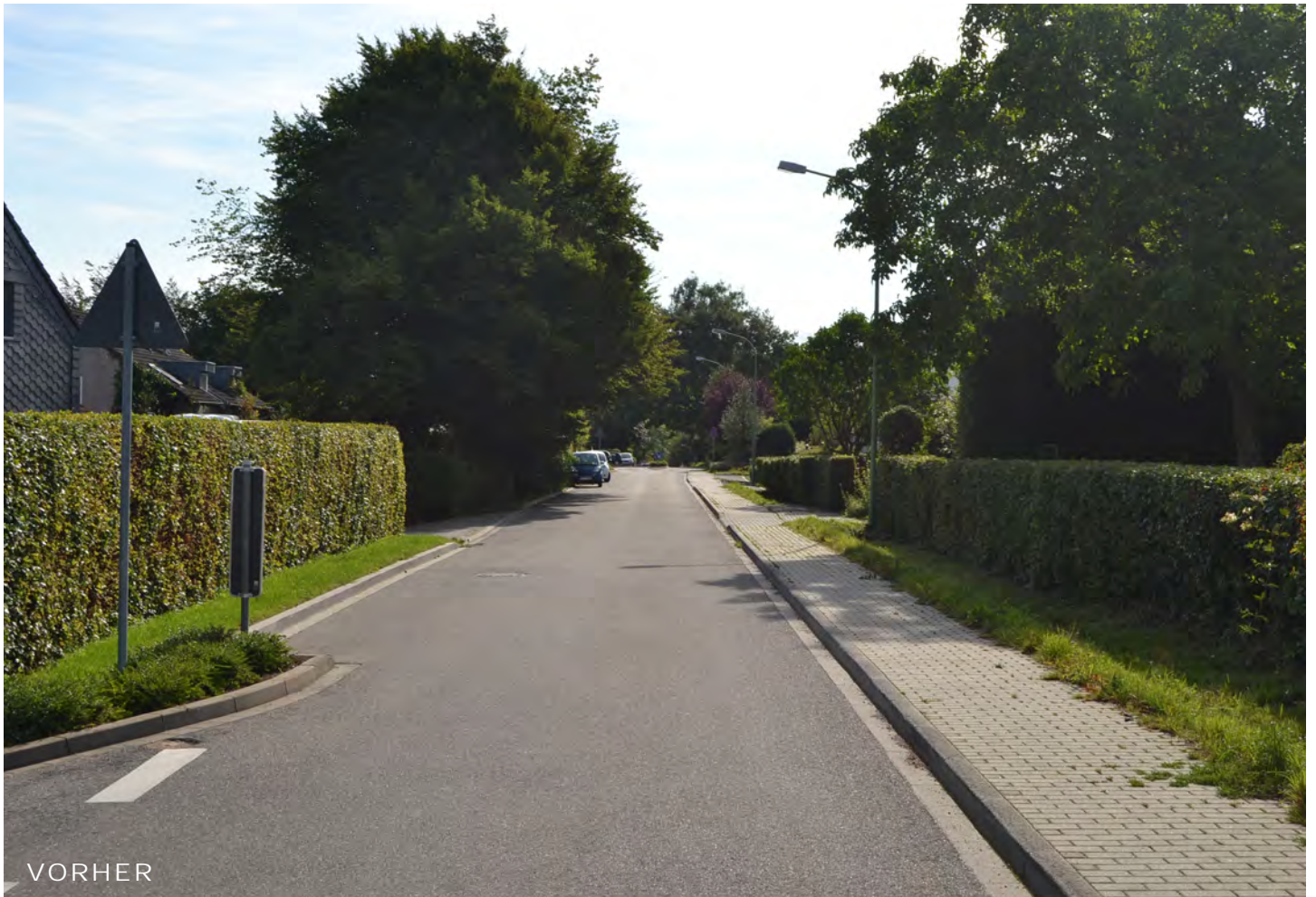
Abb. 112 Lammersdorfer Straße / ISL, August 2015
