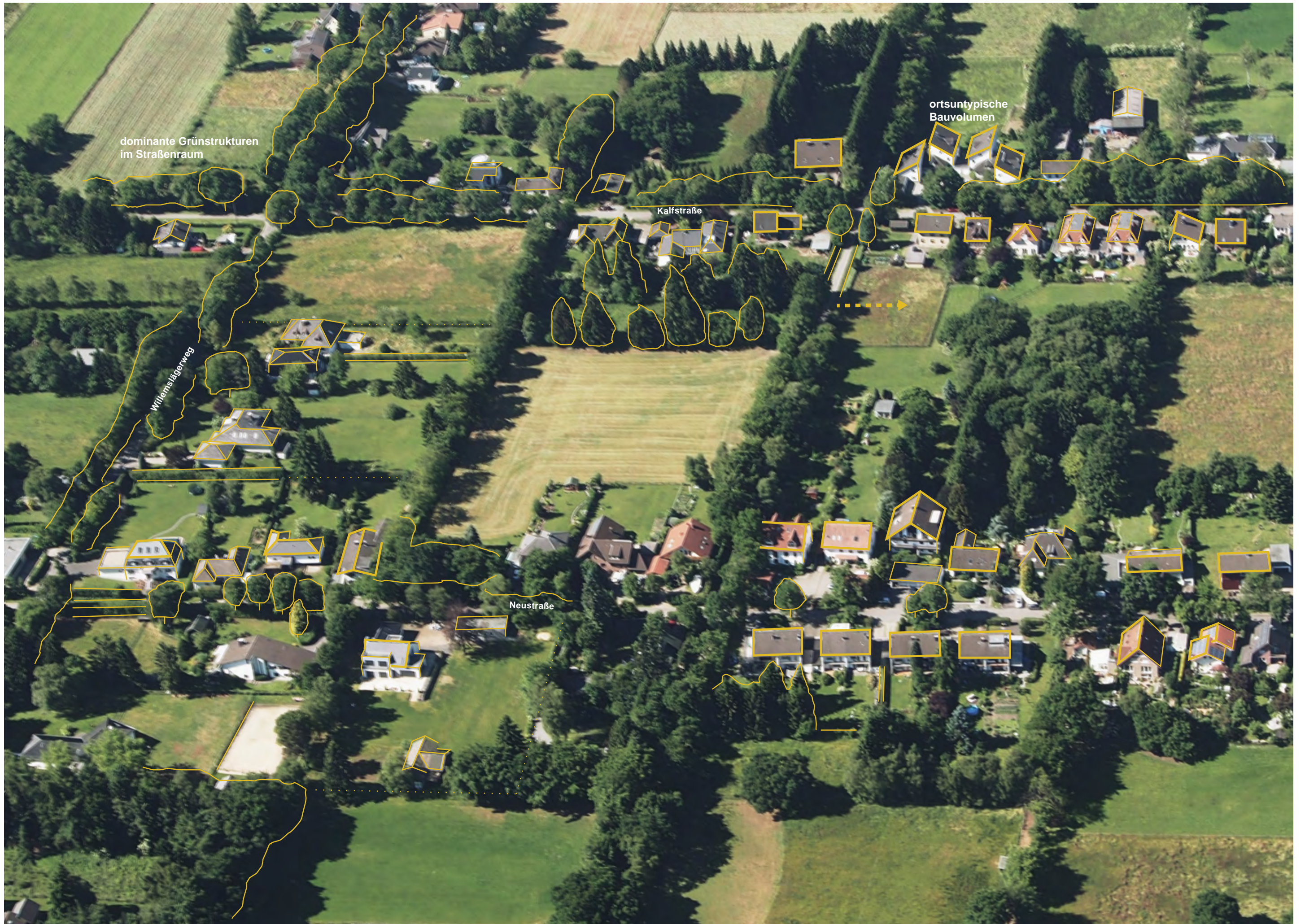
Abb. 69 Überflug: Blick auf die Schachbrettsiedlung von Norden, im Vordergrund die Neustraße / ISL, August 2015
