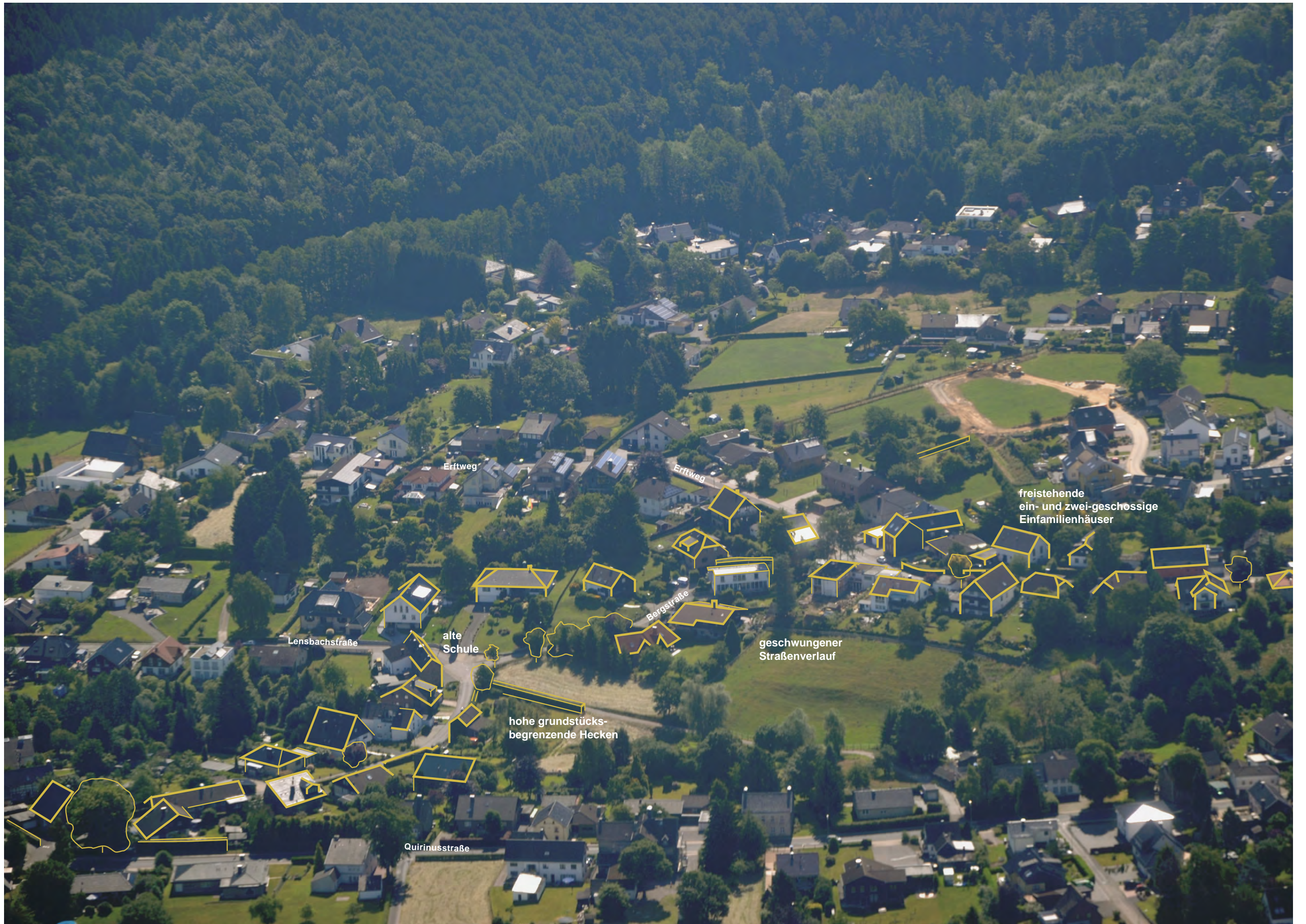
Abb. 100 Blick von Norden auf die Bergstraße / Foto: ISL August 2015
