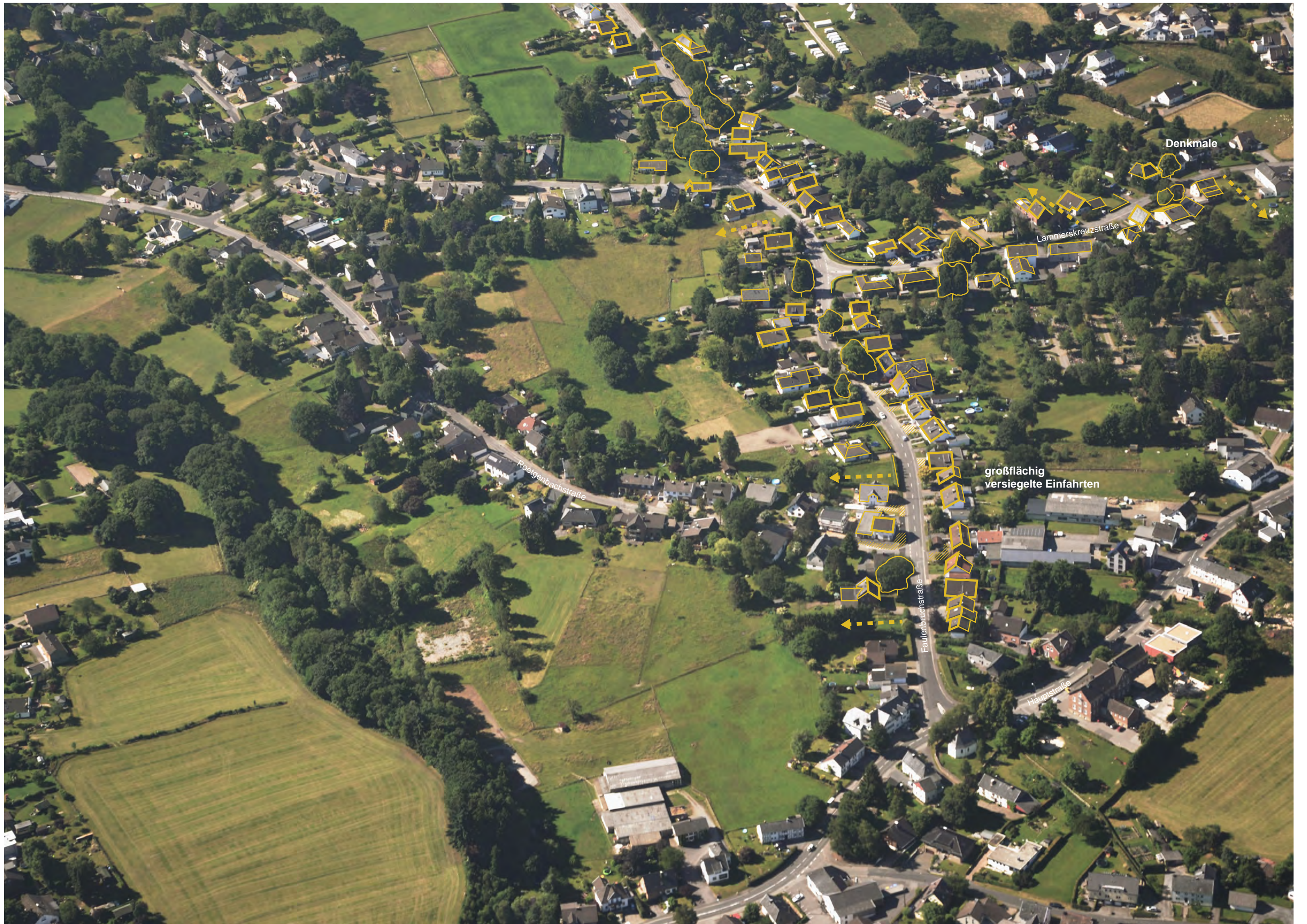
Abb. 55 Blick auf die Faulenbruch- und Roetgenbachstraße von Norden, links: Roetgenbach / ISL, August 2015
