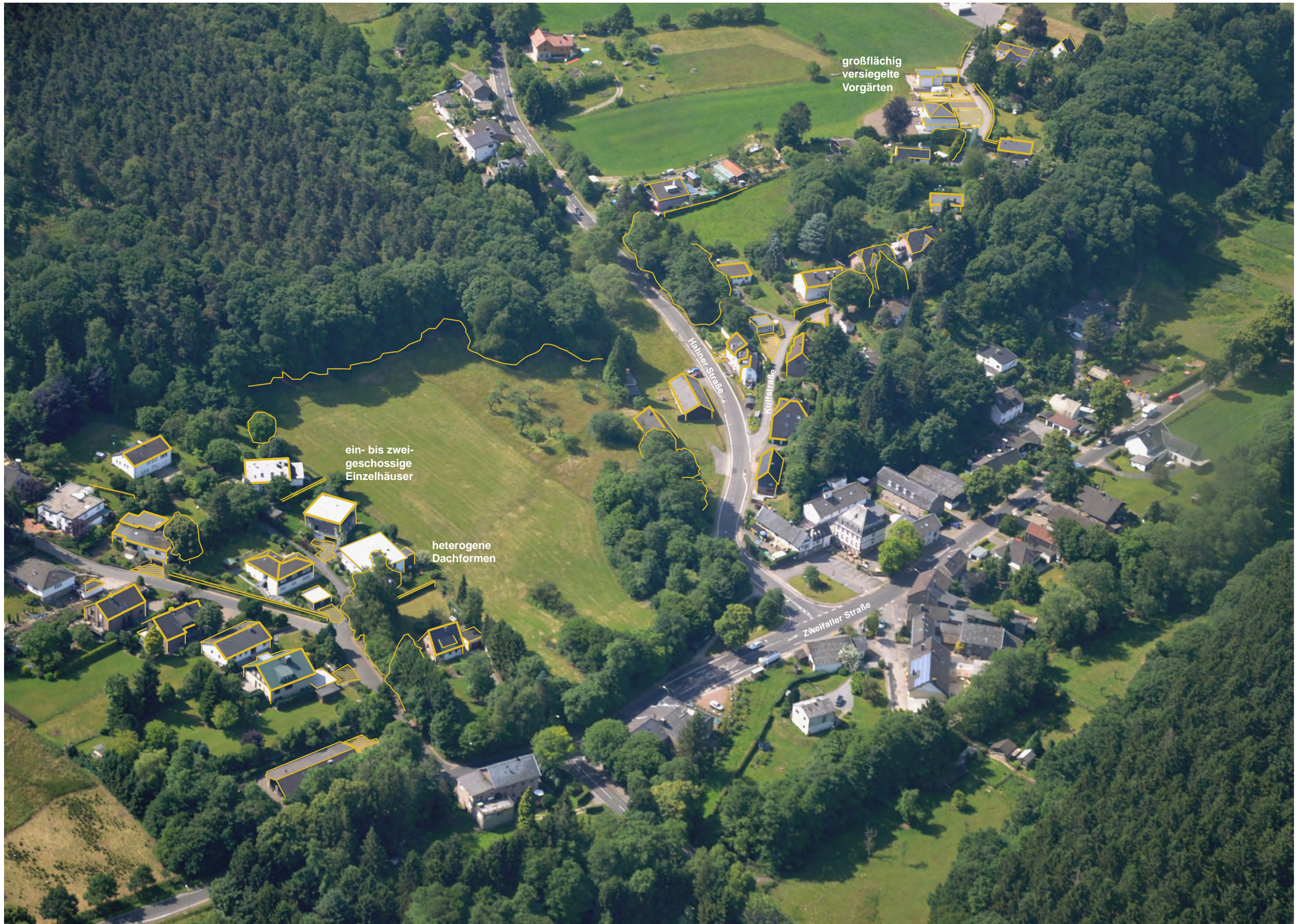
Abb. 132 Blick auf Mularthütte von Nordosten / ISL, August 2015
