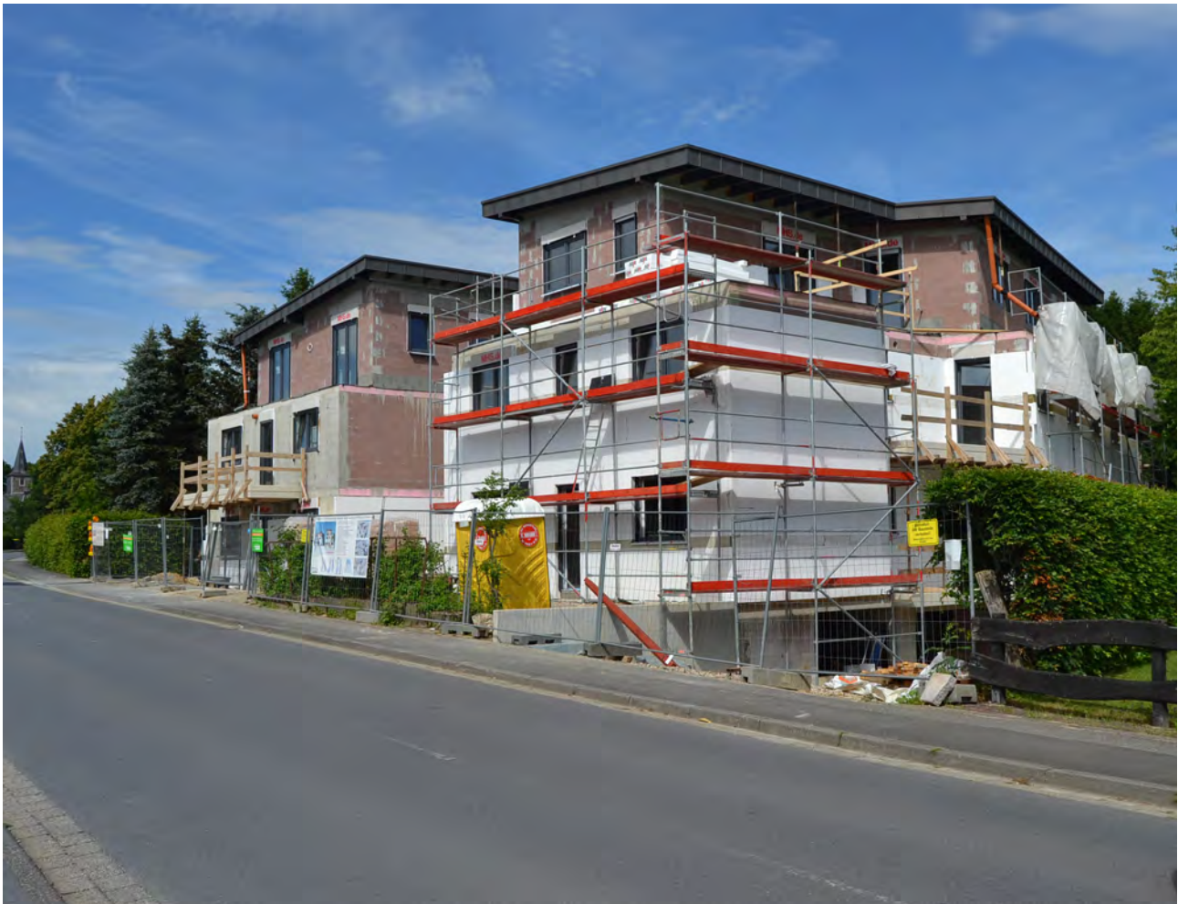
Abb. 23 Mehrfamilienhausbebauung Rosentalstraße / ISL, August 2015
