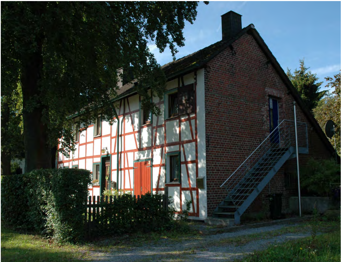
Abb. 18 Bautypologie - traufständiges Langhaus - Fachwerk / ISL, August 2015
