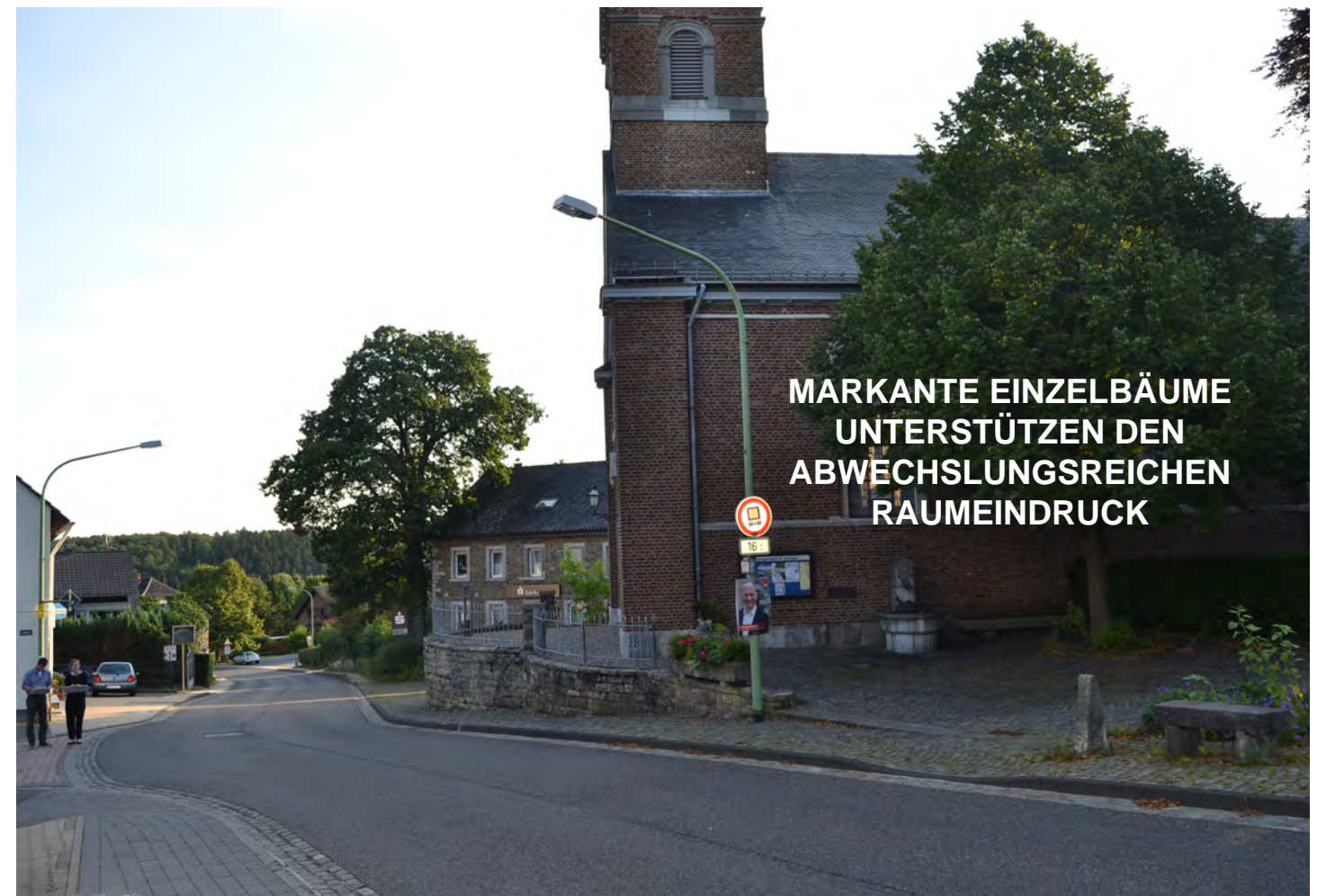
Abb. 97 Quirinusstraße, Kirche St. Antonius um 1840 erbaut / ISL, August 2015
