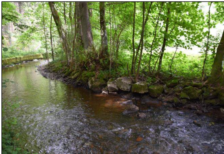
Ausgebaute Vicht im Bereich des Dammbauwerks (Betonmauer (oben links) und Blockverbau)
